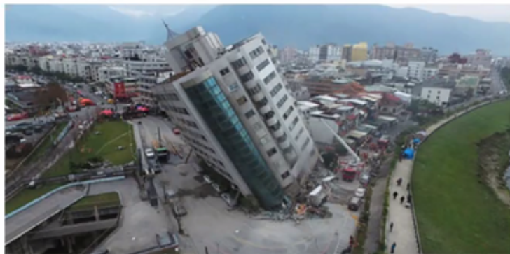
Licuefacción de suelos.
