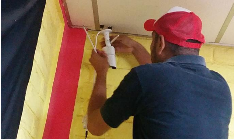
Ilustración 12: Instalación de dispositivo IoT
