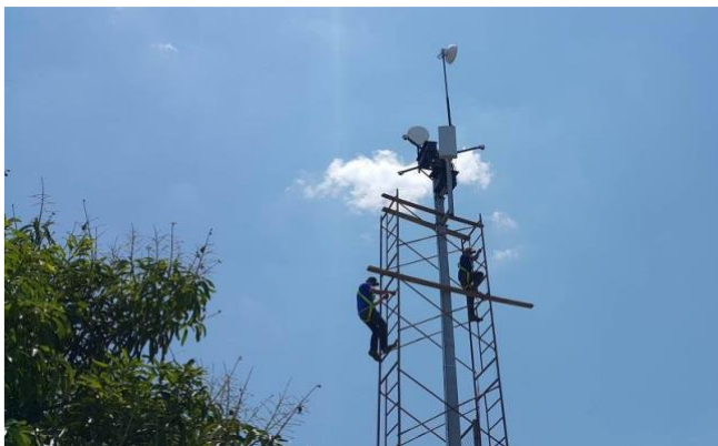
Ilustración 2. Instalación de antenas en la fase de implementación.
